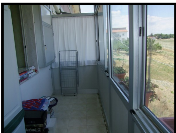
F. 23: VERANDA DELL'APPARTAMENTO UBICATA AL PIANO 1° IN CONTRADA SERRECCHIE, N. 29 – RIPALIMOSANI (CB), P.LLA 267 SUB. 2 (A/2)
