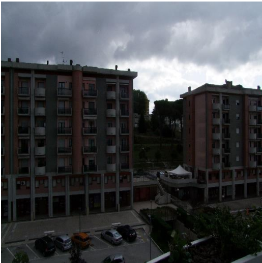
FOTO 31: VISTA DAL BALCONE AL PIANO 4°, P.LLA 2006 SUB. 99 (A/2)
