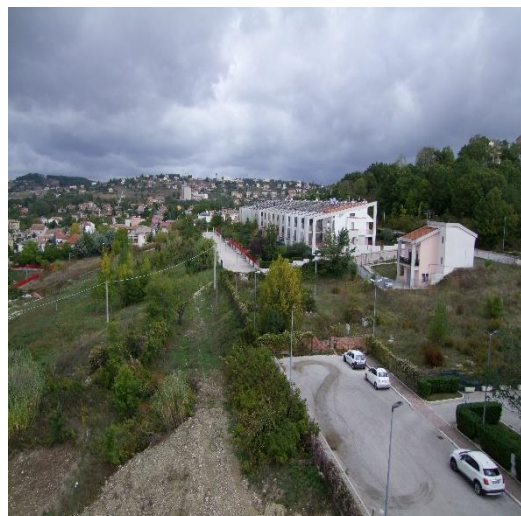
FOTO 30: VISTA DAL BALCONE AL PIANO 4°, P.LLA 2006 SUB. 99 (A/2)
