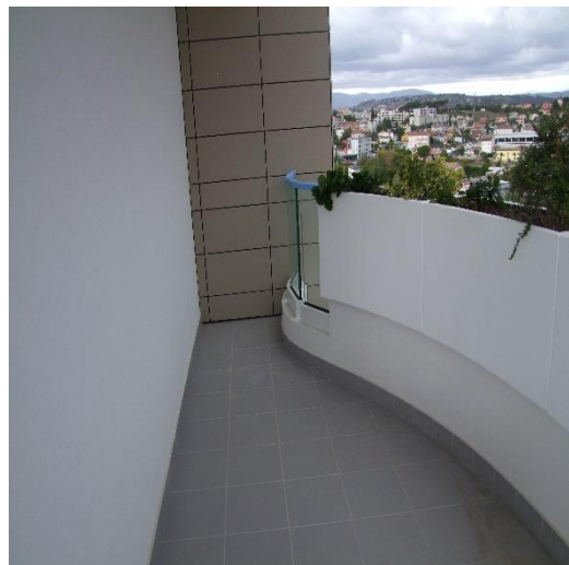
FOTO 28: BALCONE DELLA CUCINA AL PIANO 4°, P.LLA 2006 SUB. 99 (A/2)
