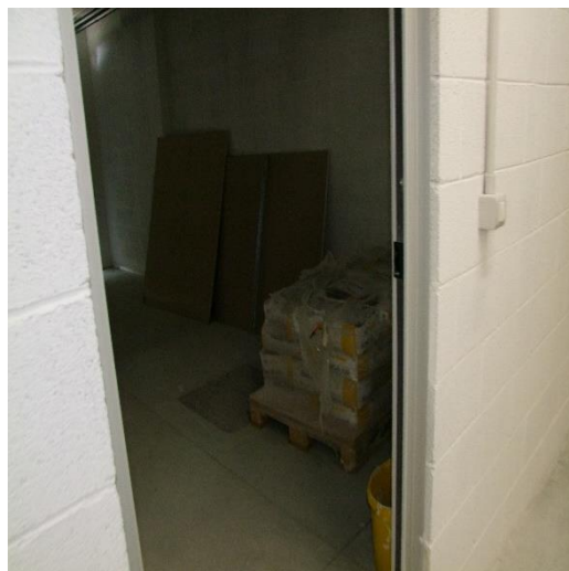
FOTO 56: INGRESSO DEL GARAGE "1" AL PIANO SEMINTERRATO, P.LLA 2006 SUB. 77 (C/6)
