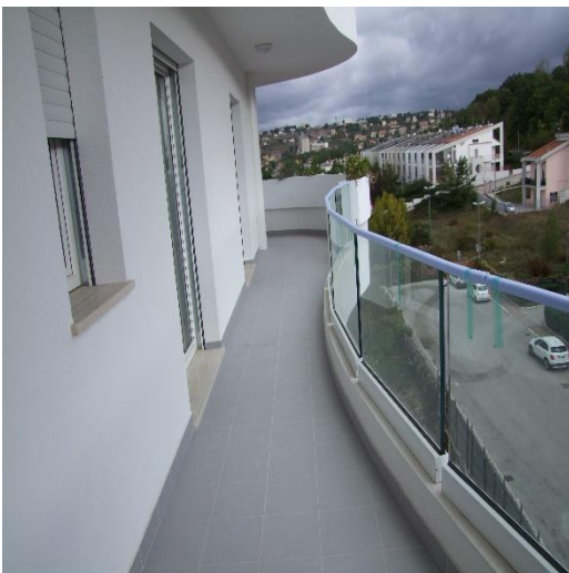
FOTO 27: BALCONE DELLA CUCINA AL PIANO 4°, P.LLA 2006 SUB. 99 (A/2)
