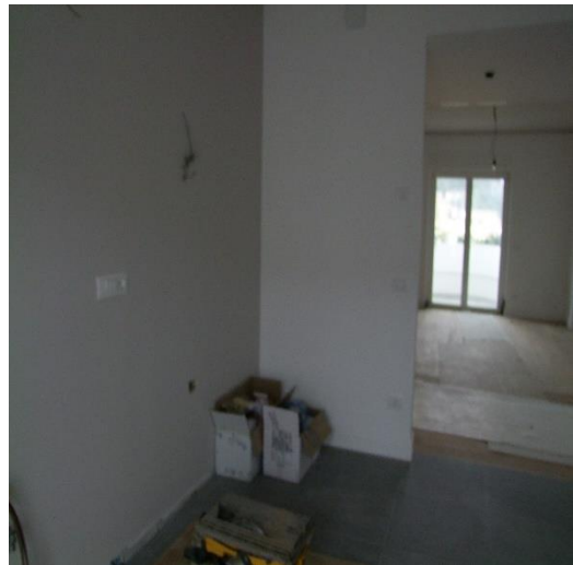
FOTO 34: INTERNO DELLA CUCINA AL PIANO 4°, P.LLA 2006 SUB. 99 (A/2)
