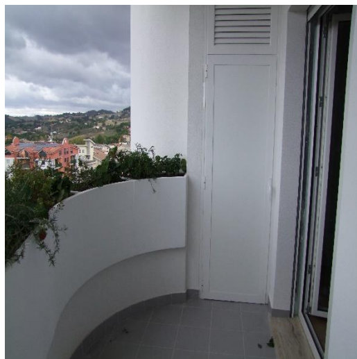
FOTO 20: BALCONE DEL SOGGIORNO AL PIANO 4°, P.LLA 2006 SUB. 99 (A/2)
