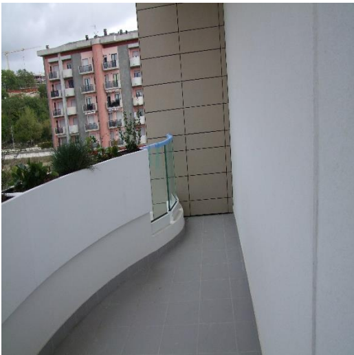
FOTO 45: BALCONE DEL LETTO "2" AL PIANO 4°, P.LLA 2006 SUB. 99 (A/2)
