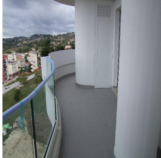
FOTO 44: BALCONE DEL LETTO "2" AL PIANO 4°, P.LLA 2006 SUB. 99 (A/2)
