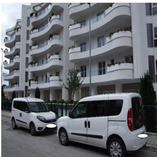
FOTO 05: FABBRICATO PLURIFAMILIARE UBICATO IN VIA ALFREDO TROMBETTA, SNC, P.LLA 2006
