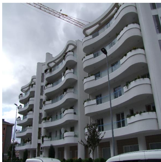
FOTO 10: FABBRICATO PLURIFAMILIARE UBICATO IN VIA ALFREDO TROMBETTA, SNC, P.LLA 2006
