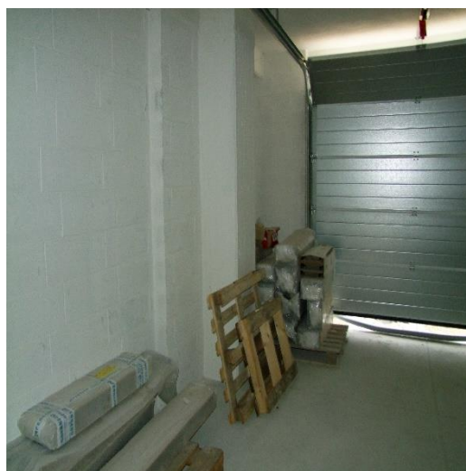
FOTO 58: INTERNO DEL GARAGE "1" AL PIANO SEMINTERRATO, P.LLA 2006 SUB. 77 (C/6)
