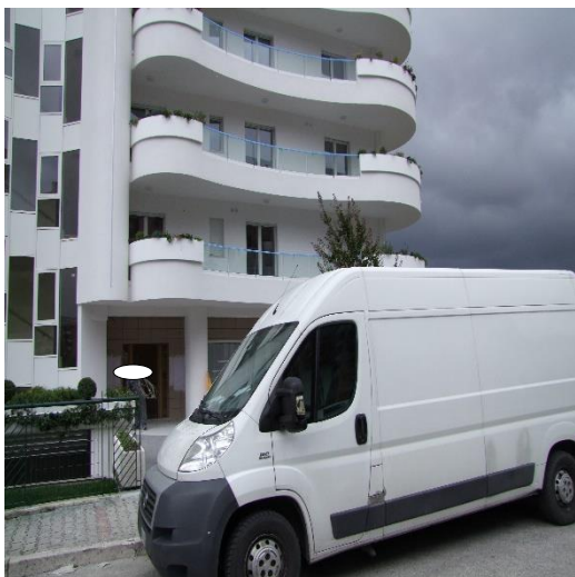
FOTO 07: FABBRICATO PLURIFAMILIARE UBICATO IN VIA ALFREDO TROMBETTA, SNC, P.LLA 2006
