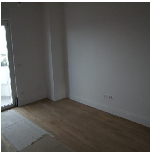
FOTO 17: INTERNO DEL SOGGIORNO AL PIANO 4°, P.LLA 2006 SUB. 99 (A/2)
