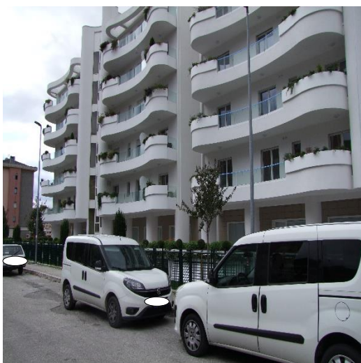
FOTO 09: FABBRICATO PLURIFAMILIARE UBICATO IN VIA ALFREDO TROMBETTA, SNC, P.LLA 2006
