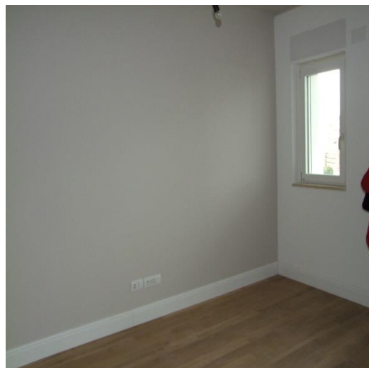
FOTO 18: INTERNO DEL SOGGIORNO AL PIANO 4°, P.LLA 2006 SUB. 99 (A/2)
