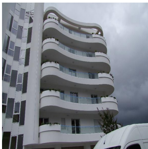
FOTO 04: FABBRICATO PLURIFAMILIARE UBICATO IN VIA ALFREDO TROMBETTA, SNC, P.LLA 2006
