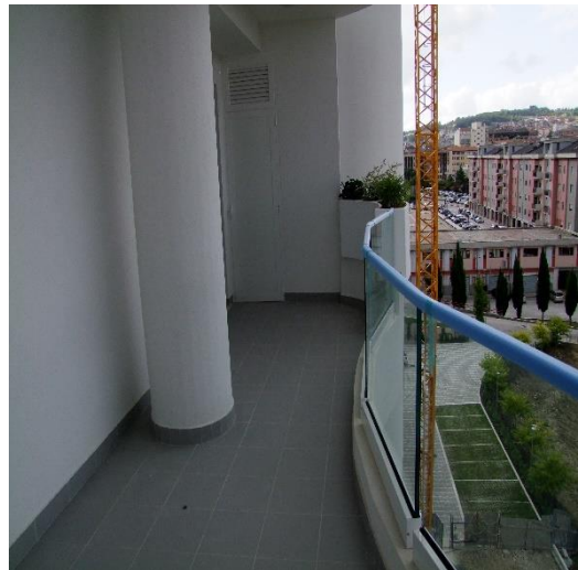
FOTO 46: BALCONE DEL LETTO "2" AL PIANO 4°, P.LLA 2006 SUB. 99 (A/2)
