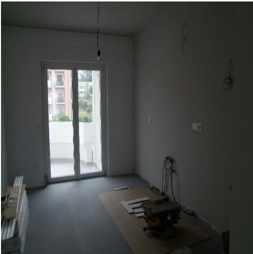
FOTO 25: INTERNO DELLA CUCINA AL PIANO 4°, P.LLA 2006 SUB. 99 (A/2)
