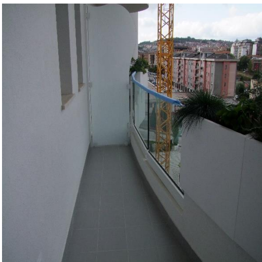
FOTO 19: BALCONE DEL SOGGIORNO AL PIANO 4°, P.LLA 2006 SUB. 99 (A/2)
