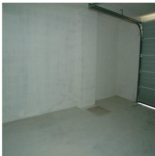
FOTO 54: INTERNO DEL GARAGE "2" AL PIANO SEMINTERRATO, P.LLA 2006 SUB. 77 (C/6)
