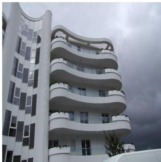
FOTO 08: FABBRICATO PLURIFAMILIARE UBICATO IN VIA ALFREDO TROMBETTA, SNC, P.LLA 2006
