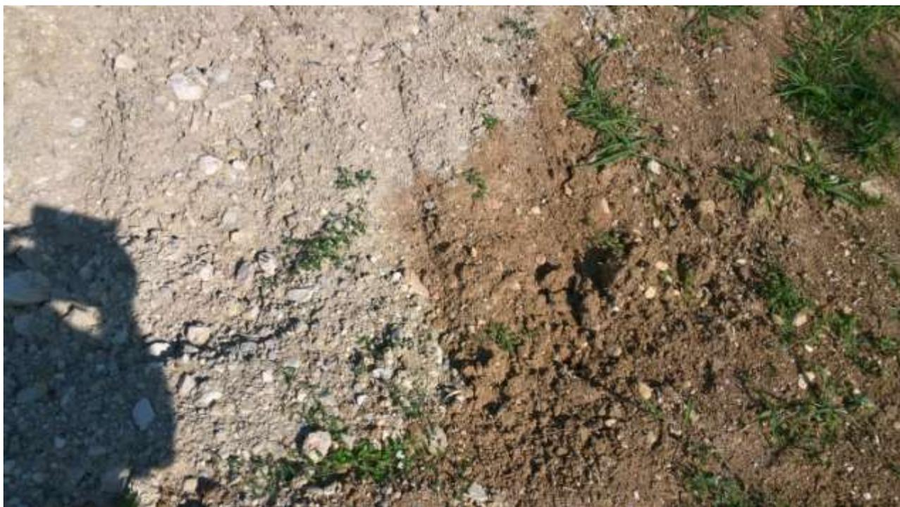
Foto 5 – Particolare del limite tra terreno ripristinato (chiaro) e originale (più scuro e senza detriti).
