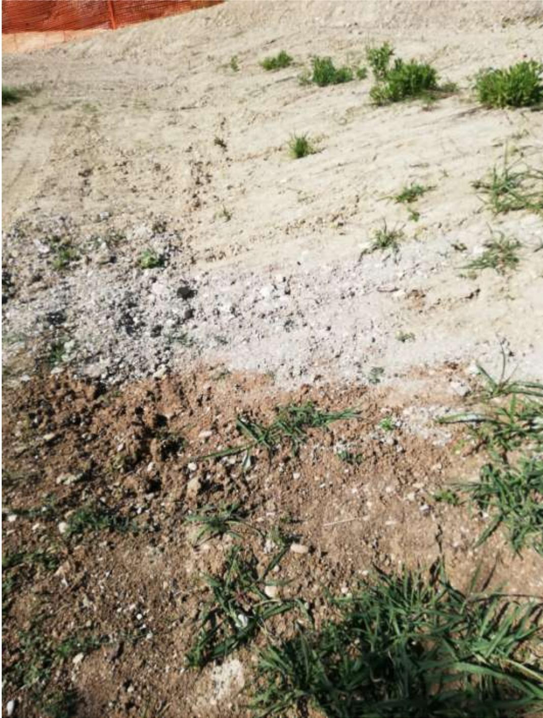
Foto 4 – Limite terreno ripristinato: notasi differenza tra il terreno ripristinato (chiaro in alto) e quello originale (più scuro in basso).
