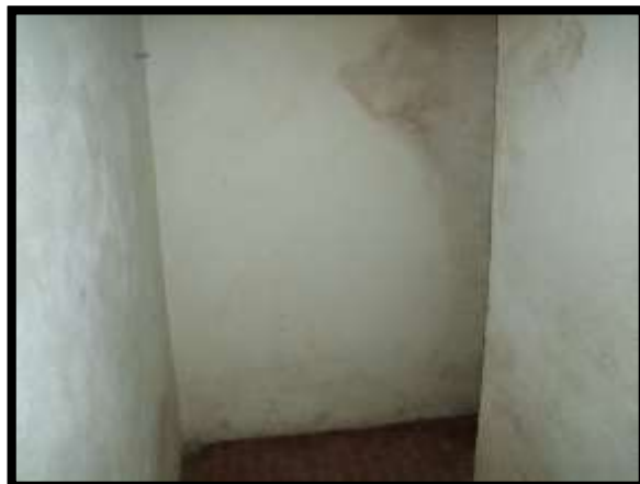
F. 16: INTERNO DELLA CANTINA N. "3E" UBICATO AL PIANO TERRA DELLA SCALA "E" IN VIA GIACOMO LEOPARDI N. 53/E, IN LOCALITÀ VAZZIERI, CAMPOBASSO (CB), P.LLA 190 SUB. 72 (A/2)
