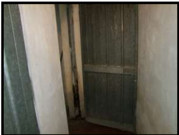
F. 15: INGRESSO DELLA CANTINA N. "3E" UBICATO AL PIANO TERRA DELLA SCALA "E" IN VIA GIACOMO LEOPARDI N. 53/E, IN LOCALITÀ VAZZIERI, CAMPOBASSO (CB), P.LLA 190 SUB. 72 (A/2)
