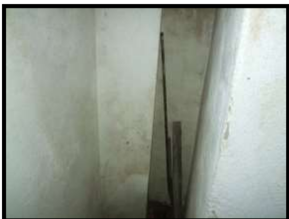
F. 17: INTERNO DELLA CANTINA N. "3E" UBICATO AL PIANO TERRA DELLA SCALA "E" IN VIA GIACOMO LEOPARDI N. 53/E, IN LOCALITÀ VAZZIERI, CAMPOBASSO (CB), P.LLA 190 SUB. 72 (A/2)
