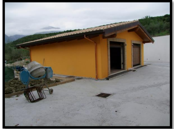
F. 26: ACCESSO AL GARAGE UBICATO AL PIANO TERRA IN CONTRADA QUARTO DA CAPO, S.N.C. – CASOLI (CH), P.LLA 4137
