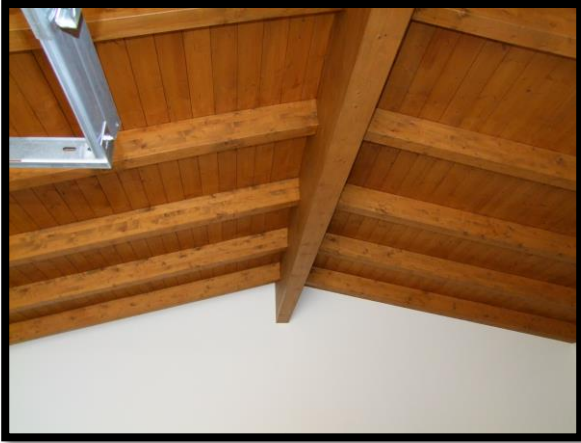
F. 31: INTERNO DEL GARAGE UBICATO AL PIANO TERRA IN CONTRADA QUARTO DA CAPO, S.N.C. – CASOLI (CH), P.LLA 4137 SUB. 3 (C/6)
