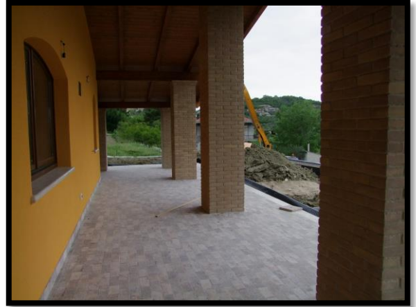
F. 14: PORTICO DELL'ABITAZIONE UBICATO AL PIANO TERRA IN CONTRADA QUARTO DA CAPO, S.N.C. – CASOLI (CH), P.LLA 4137 SUB. 2 (A/7)
