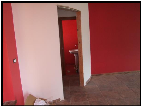
F. 07: INTERNO DELL'ABITAZIONE UBICATA AL PIANO TERRA IN CONTRADA QUARTO DA CAPO, S.N.C. – CASOLI (CH), P.LLA 4137 SUB. 2 (A/7)
