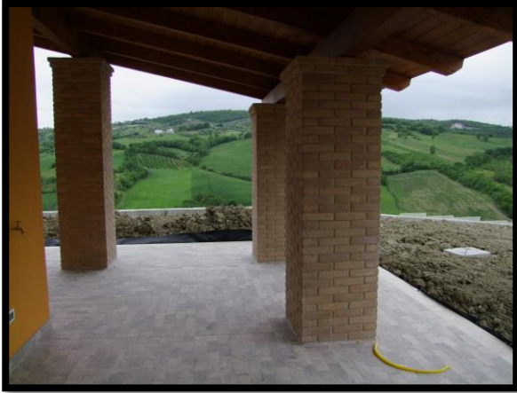
F. 13: PORTICO DELL'ABITAZIONE UBICATO AL PIANO TERRA IN CONTRADA QUARTO DA CAPO, S.N.C. – CASOLI (CH), P.LLA 4137 SUB. 2 (A/7)
