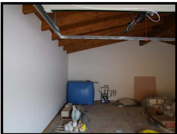
F. 29: INTERNO DEL GARAGE UBICATO AL PIANO TERRA IN CONTRADA QUARTO DA CAPO, S.N.C. – CASOLI (CH), P.LLA 4137 SUB. 3 (C/6)
