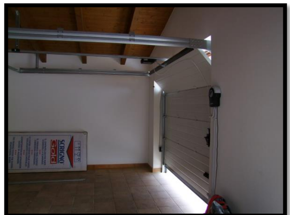
F. 30: INTERNO DEL GARAGE UBICATO AL PIANO TERRA IN CONTRADA QUARTO DA CAPO, S.N.C. – CASOLI (CH), P.LLA 4137 SUB. 3 (C/6)
