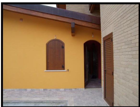
F. 05: INGRESSO SECONDARIO UBICATO AL PIANO TERRA IN CONTRADA QUARTO DA CAPO, S.N.C. – CASOLI (CH), P.LLA 4137 SUB. 2 (A/7)
