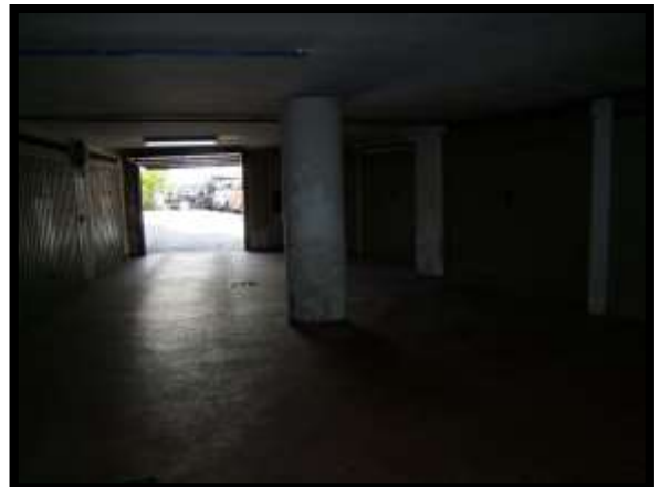
F. 22: ACCESSO AL GARAGE N. "4" UBICATO AL PIANO SEMINTERRATO IN VIA QUINTINO SELLA, N. 12, LOCALITÀ CESE – CAMPOBASSO (CB), P.LLA 133
