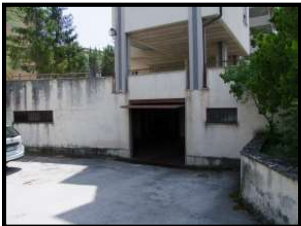
F. 25: ACCESSO AL GARAGE N. "4" UBICATO AL PIANO SEMINTERRATO IN VIA QUINTINO SELLA, N. 12, LOCALITÀ CESE – CAMPOBASSO (CB), P.LLA 133
