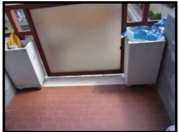
F. 16: BALCONE DELL'APPARTAMENTO, INTERNO "6" UBICATO AL PIANO 3° IN VIA QUINTINO SELLA, N. 12, LOCALITÀ CESE – CAMPOBASSO (CB), P.LLA 133 SUB. 42 (A/2)
