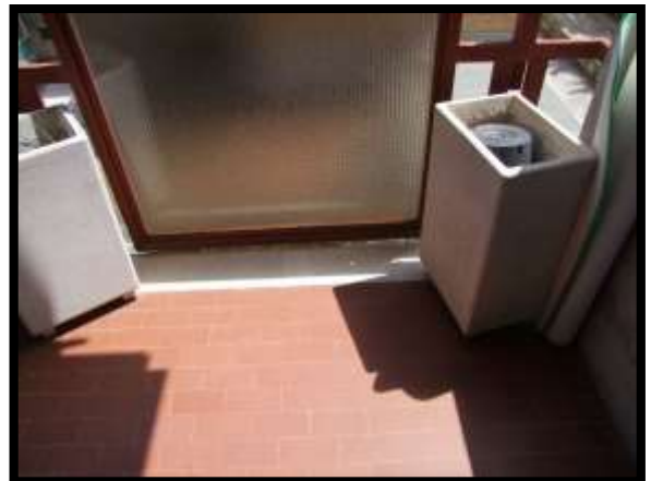
F. 10: BALCONE DELL'APPARTAMENTO, INTERNO "6" UBICATO AL PIANO 3° IN VIA QUINTINO SELLA, N. 12, LOCALITÀ CESE – CAMPOBASSO (CB), P.LLA 133 SUB. 42 (A/2)
