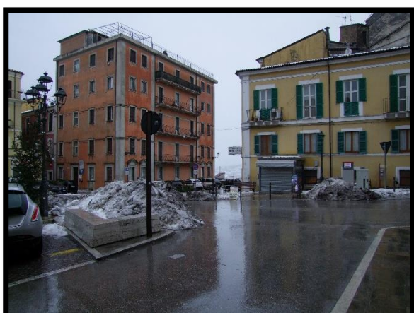
F. 05: FABBRICATO PLURIFAMILIARE VISTO DA PIAZZA MATTEOTTI, QUARTIERE MADONNA DEI SETTE DOLORI, CHIETI (CH), P.LLA 478
