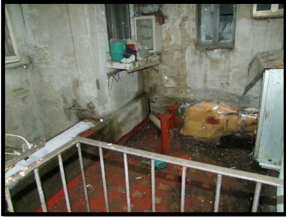
F. 31: CORTILE COMUNE UBICATO AL PIANO RIALZATO IN VIA CESARE DE LOLLIS, N. 90, QUARTIERE MADONNA DEI SETTE DOLORI – CHIETI (CH), P.LLA 478
