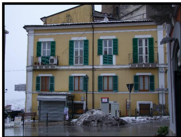
F. 04: FABBRICATO PLURIFAMILIARE VISTO DA PIAZZA MATTEOTTI, QUARTIERE MADONNA DEI SETTE DOLORI, CHIETI (CH), P.LLA 478
