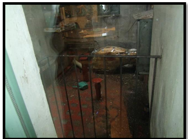
F. 30: CORTILE COMUNE UBICATO AL PIANO RIALZATO IN VIA CESARE DE LOLLIS, N. 90, QUARTIERE MADONNA DEI SETTE DOLORI – CHIETI (CH), P.LLA 478
