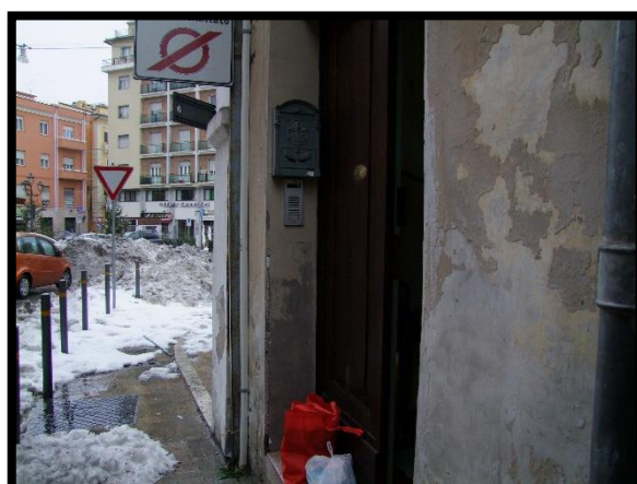
F. 06: INGRESSO DELL'APPARTAMENTO UBICATO AL PIANO RIALZATO IN VIA CESARE DE LOLLIS, N. 90, QUARTIERE MADONNA DEI SETTE DOLORI – CHIETI (CH), P.LLA 478 SUB. 16
