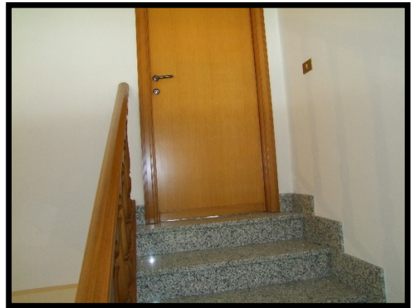
F. 34: ACCESSO ALLA SOFFITTA UBICATA AL PIANO 2° SOTTOTETTO IN VIA MADDALENA, N. 71 – VASTO (CH), P.LLA 705 SUB. 4 (A/7)
