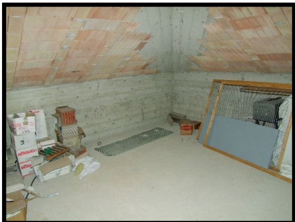
F. 39: INTERNO DELLA SOFFITTA UBICATA AL PIANO 2° SOTTOTETTO IN VIA MADDALENA, N. 71 – VASTO (CH), P.LLA 705 SUB. 4 (A/7)
