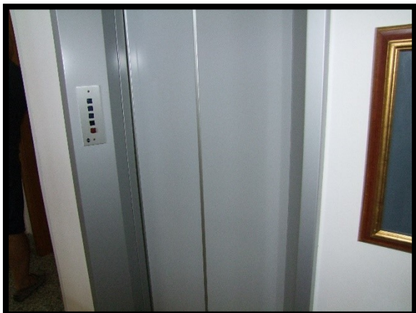
F. 21: ASCENSORE DELL'ABITAZIONE UBICATA AL PIANO TERRA IN VIA MADDALENA, N. 71 – VASTO (CH), P.LLA 705 SUB. 4 (A/7)
