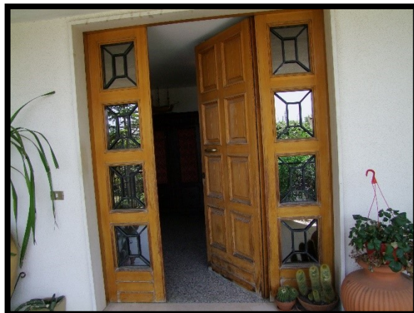
F. 14: INGRESSO DELL'ABITAZIONE UBICATA AL PIANO TERRA IN VIA MADDALENA, N. 71 – VASTO (CH), P.LLA 705 SUB. 4 (A/7)
