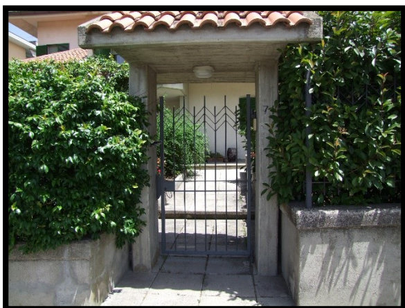
F. 05: INGRESSO DEL FABBRICATO UNIFAMILIARE UBICATO IN VIA MADDALENA, N. 71 – VASTO (CH), P.LLE 705 SUB. 1 (C/6) E SUB. 4 (A/7)
