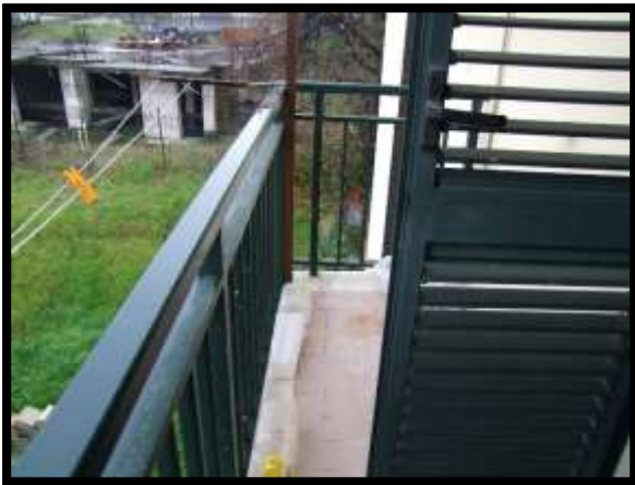
F. 21: BALCONE DELL'APPARTAMENTO UBICATO AL PIANO 2° IN VIA TRENTO E TRIESTE, N. 19/B – SAN SALVO (CH), P.LLA 1357 SUB. 3 (A/3)
