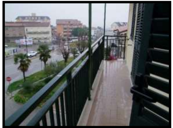
F. 34: BALCONE DELL'APPARTAMENTO UBICATO AL PIANO 2° IN VIA TRENTO E TRIESTE, N. 19/B – SAN SALVO (CH), P.LLA 1357 SUB. 3 (A/3)
