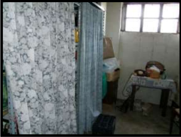
F. 37: INTERNO DEL MAGAZZINO UBICATO AL PIANO TERRA IN VIALE SAN GIOVANNI IN VENERE, N. 10, FOSSACESIA (CH), P.LLA 4230 SUB. 5 (D/10), NON OGGETTO DI VALUTAZIONE
