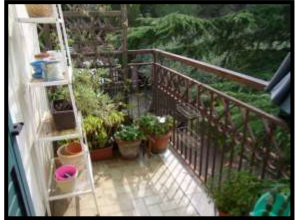
F. 22: BALCONE DELL'APPARTAMENTO UBICATO AL PIANO 1° IN VIALE SAN GIOVANNI IN VENERE, N. 10 – FOSSACESIA (CH), P.LLA 4230 SUB. 4 (A/3)
