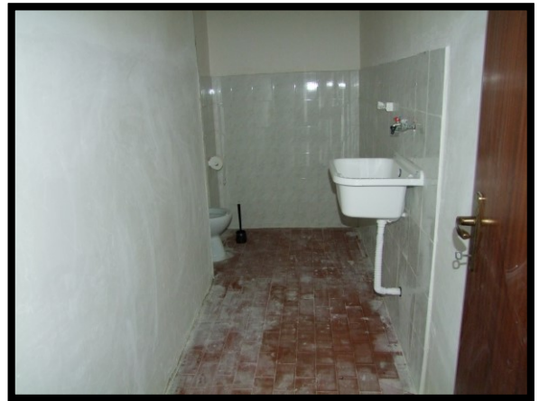
F. 34: INTERNO DEL W.C. UBICATO AL PIANO SEMINTERRATO IN VIA TAVERNA, S.N.C. – MONTAQUILA (IS), P.LLA 268 (A7)
