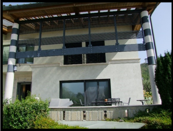
F. 07: FABBRICATO UNIFAMILIARE UBICATO IN VIA MARCHESE DEL PRETE, N. 17 – POZZILLI (IS), P.LLE 270 SUB. 4 (A/7) E 177, 203, 343, 346, 307, 308, 309, 310, 311, 422, 424 AL N.C.T.
