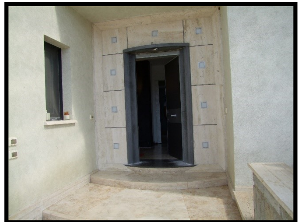
F. 10: INGRESSO DELL'ABITAZIONE UBICATO AL PIANO TERRA IN VIA MARCHESE DEL PRETE, N. 17 – POZZILLI (IS), P.LLA 270 SUB. 4 (A/7)
