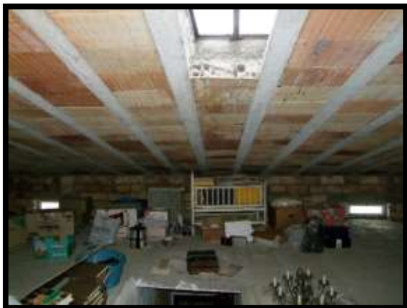
F. 37: INTERNO DELLA SOFFITTA UBICATO AL PIANO 3° SOTTOTETTO IN VIALE CALVARIO, N. 64 – CASTELMAURO (CB), PORZIONE NON ACCATASTATA
