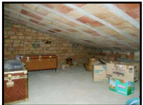
F. 34: INTERNO DELLA SOFFITTA UBICATO AL PIANO 3° SOTTOTETTO IN VIALE CALVARIO, N. 64 – CASTELMAURO (CB), PORZIONE NON ACCATASTATA
