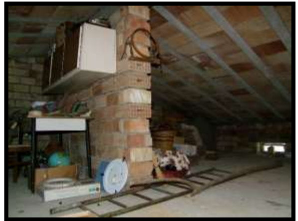
F. 32: INTERNO DELLA SOFFITTA UBICATO AL PIANO 3° SOTTOTETTO IN VIALE CALVARIO, N. 64 – CASTELMAURO (CB), PORZIONE NON ACCATASTATA
