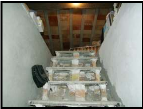
F. 31: ACCESSO ALLA SOFFITTA UBICATA AL PIANO 3° SOTTOTETTO IN VIALE CALVARIO, N. 64 – CASTELMAURO (CB), PORZIONE NON ACCATASTATA
