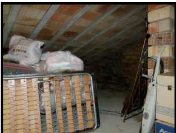
F. 33: INTERNO DELLA SOFFITTA UBICATO AL PIANO 3° SOTTOTETTO IN VIALE CALVARIO, N. 64 – CASTELMAURO (CB), PORZIONE NON ACCATASTATA
