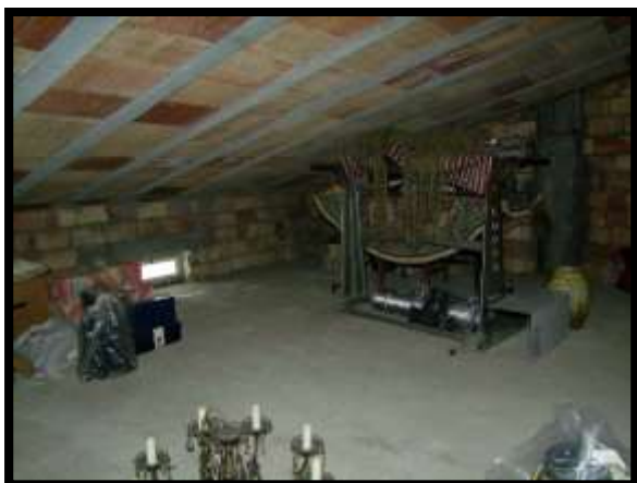
F. 35: INTERNO DELLA SOFFITTA UBICATO AL PIANO 3° SOTTOTETTO IN VIALE CALVARIO, N. 64 – CASTELMAURO (CB), PORZIONE NON ACCATASTATA
