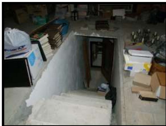
F. 36: INTERNO DELLA SOFFITTA UBICATO AL PIANO 3° SOTTOTETTO IN VIALE CALVARIO, N. 64 – CASTELMAURO (CB), PORZIONE NON ACCATASTATA
