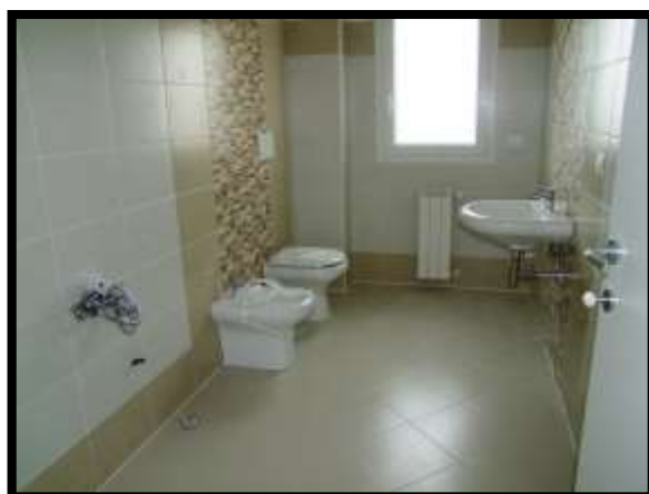
F. 24: INTERNO DELL'APPARTAMENTO INT. "32" UBICATO AL PIANO 5° IN VIA GIUSEPPE SPATARO, N. 4/D, LOCALITÀ SANTA RITA – LANCIANO (CH), P.LLA 4605 SUB. 37 (A/2)
