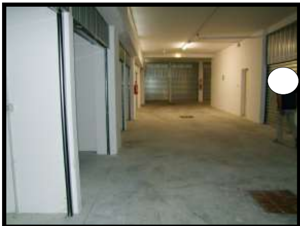
F. 31: AREA DI MANOCRA DEI GARAGE UBICATI AL PIANO 1° SOTTOSTRADA IN VIA GIUSEPPE SPATARO, N. 4/D, LOCALITÀ SANTA RITA – LANCIANO (CH), P.LLA 4605 SUB. 2 (C/6)
