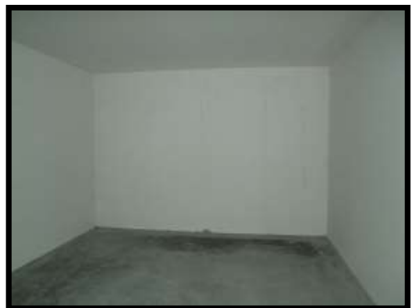
F. 30: INTERNO DEL GARAGE INT. "17" UBICATO AL PIANO 1° SOTTOSTRADA IN VIA GIUSEPPE SPATARO, N. 4/D, LOCALITÀ SANTA RITA – LANCIANO (CH), P.LLA 4605 SUB. 60 (C/6)
