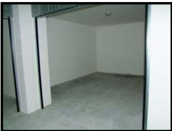
F. 29: INGRESSO DEL GARAGE INT. "17" UBICATO AL PIANO 1° SOTTOSTRADA IN VIA GIUSEPPE SPATARO, N. 4/D, LOCALITÀ SANTA RITA – LANCIANO (CH), P.LLA 4605 SUB. 60 (C/6)
