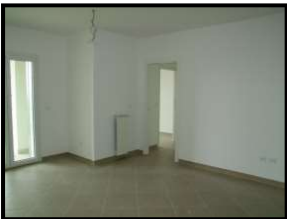
F. 17: INTERNO DELL'APPARTAMENTO INT. "32" UBICATO AL PIANO 5° IN VIA GIUSEPPE SPATARO, N. 4/D, LOCALITÀ SANTA RITA – LANCIANO (CH), P.LLA 4605 SUB. 37 (A/2)
