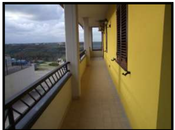
F. 34: PORTICO DELL'ABITAZIONE UBICATO AL PIANO RIALZATO IN CONTRADA PIANE FAVARO, N. 34 – ROCCA SAN GIOVANNI (CH), P.LLE 4157 SUB. 2 (A/7)
