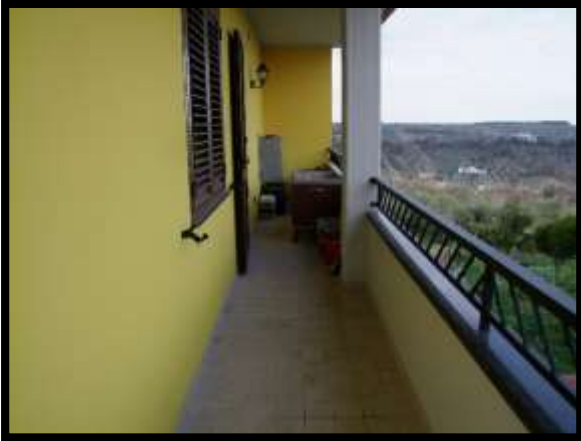
F. 35: PORTICO DELL'ABITAZIONE UBICATO AL PIANO RIALZATO IN CONTRADA PIANE FAVARO, N. 34 – ROCCA SAN GIOVANNI (CH), P.LLE 4157 SUB. 2 (A/7)
