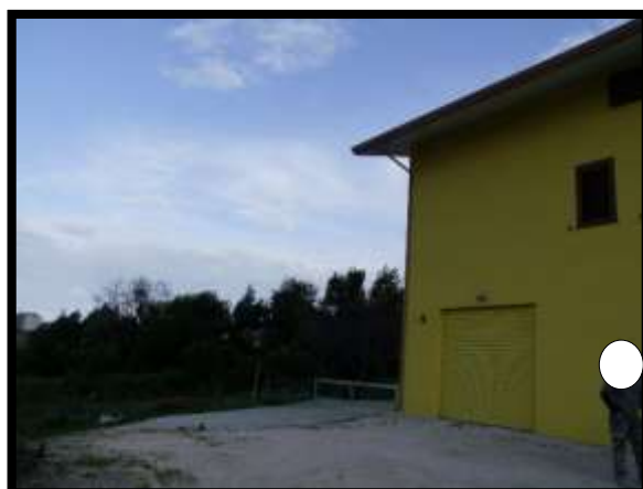
F. 64: CORTE ESCLUSIVA UBICATA AL PIANO RIALZATO IN CONTRADA PIANE FAVARO, N. 34 – ROCCA SAN GIOVANNI (CH), P.LLE 4157 SUB. 1 (B.C.N.C.)
