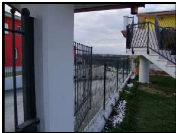
F. 62: CORTE ESCLUSIVA UBICATA AL PIANO RIALZATO IN CONTRADA PIANE FAVARO, N. 34 – ROCCA SAN GIOVANNI (CH), P.LLE 4157 SUB. 1 (B.C.N.C.)
