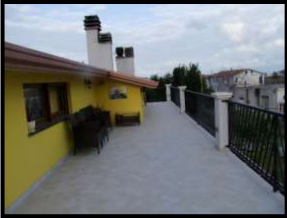
F. 47: TERRAZZO DELLA SOFFITTA UBICATO AL PIANO 1° SOTTOTETTO IN CONTRADA PIANE FAVARO, N. 34 – ROCCA SAN GIOVANNI (CH), P.LLE 4157 SUB. 2 (A/7)
