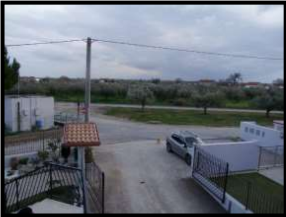
F. 49: VISTA DALLA SOFFITTA UBICATA AL PIANO 1° SOTTOTETTO IN CONTRADA PIANE FAVARO, N. 34 – ROCCA SAN GIOVANNI (CH), P.LLE 4157 SUB. 2 (A/7)
