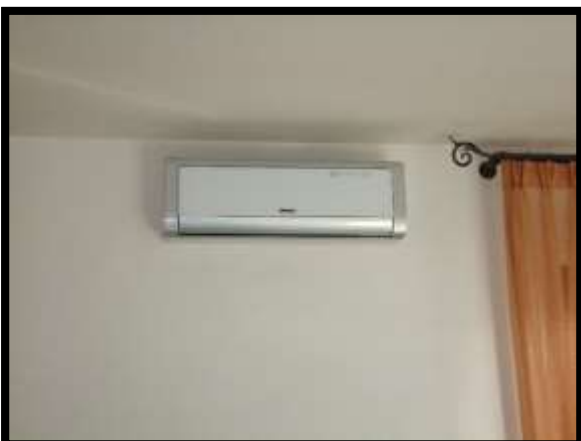
F. 21: INTERNO DELL'ABITAZIONE UBICATO AL PIANO RIALZATO IN CONTRADA PIANE FAVARO, N. 34 – ROCCA SAN GIOVANNI (CH), P.LLE 4157 SUB. 2 (A/7)
