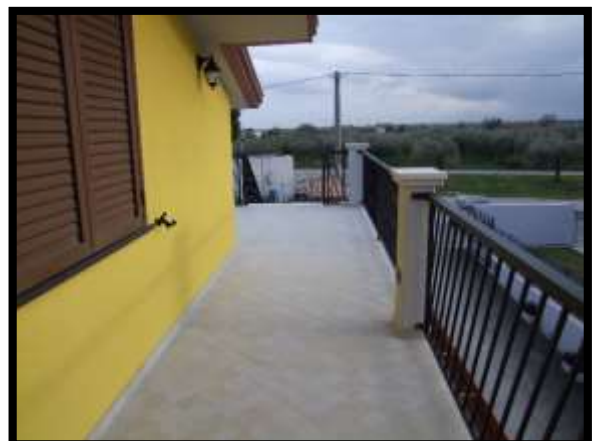
F. 46: TERRAZZO DELLA SOFFITTA UBICATO AL PIANO 1° SOTTOTETTO IN CONTRADA PIANE FAVARO, N. 34 – ROCCA SAN GIOVANNI (CH), P.LLE 4157 SUB. 2 (A/7)
