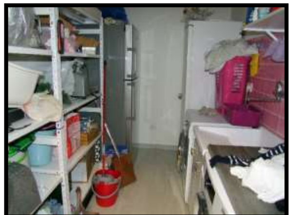
F. 40: INTERNO DELLA SOFFITTA UBICATO AL PIANO 1° SOTTOTETTO IN CONTRADA PIANE FAVARO, N. 34 – ROCCA SAN GIOVANNI (CH), P.LLE 4157 SUB. 2 (A/7)
