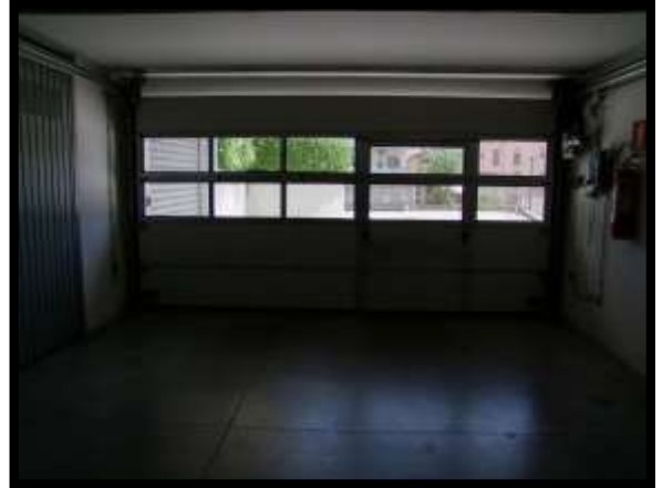
F. 26: ACCESSO AL GARAGE UBICATO AL PIANO 1° SOTTOSTRADA IN VIA DEL VERDE, N. 29, – LANCIANO (CH), P.LLA 4577
