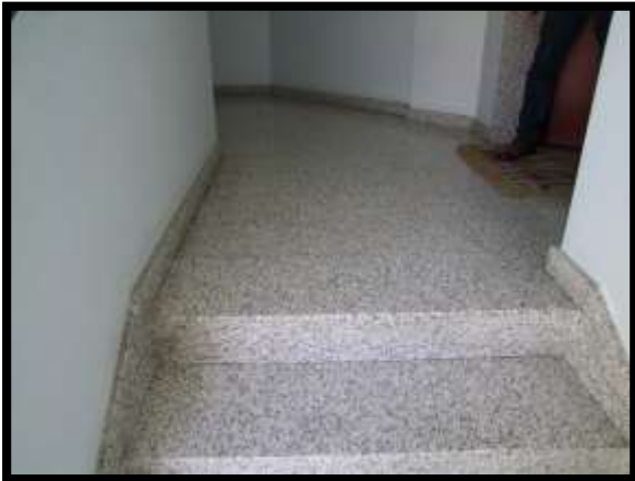
F. 07: ACCESSO ALL'APPARTAMENTO INTERNO "8" UBICATO AL PIANO 2° DELLA SCALA "A" IN VIA DEL VERDE, N. 29, – LANCIANO (CH), P.LLA 4577 SUB. 2 (B.C.N.C.)
