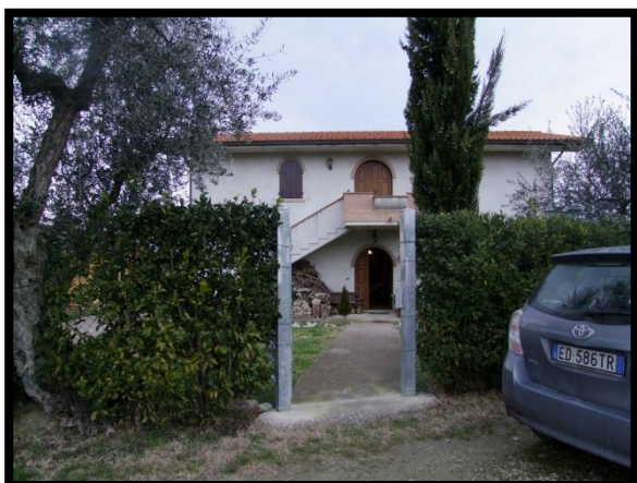
F. 05: FABBRICATO UNIFAMILIARE IN VIA SOLE, S.N.C., C.DA TORRE SAN ROCCO – PINETO (TE), P.LLA 31
