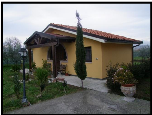
F. 29: RIMESSA, RIPOSTIGLIO E STALLE POSTE AL PIANO TERRA, P.LLA 31 AL N.C.E.U. (CAMBIO DI DESTINAZIONE D'USO IN PLURIUSO)
