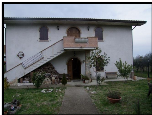
F. 06: FABBRICATO UNIFAMILIARE IN VIA SOLE, S.N.C., C.DA TORRE SAN ROCCO – PINETO (TE), P.LLA 31
