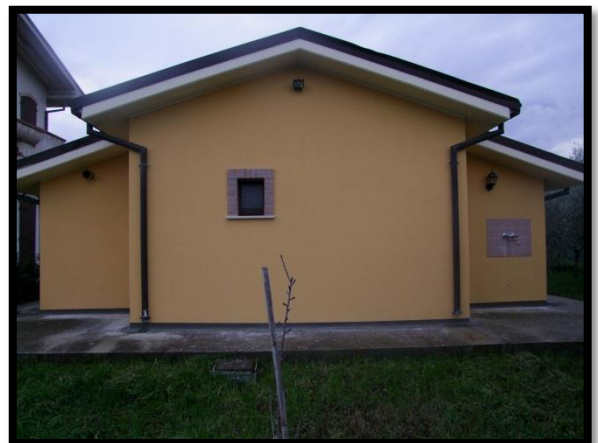
F. 30: RIMESSA, RIPOSTIGLIO E STALLE POSTE AL PIANO TERRA, P.LLA 31 AL N.C.E.U. (CAMBIO DI DESTINAZIONE D'USO IN PLURIUSO)
