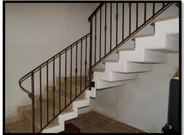
F. 16: ACCESSO AL PIANO 1° DEL FABBRICATO UNIFAMILIARE, P.LLA 31 AL N.C.E.U.
