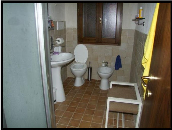
F. 15: INTERNO DELL'ABITAZIONE POSTA AL PIANO TERRA, P.LLA 31 AL N.C.E.U. (PORZIONE VALUTATA ED ASSENTITA COME CANTINA)
