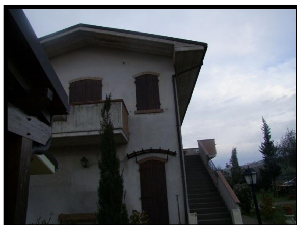
F. 36: FABBRICATO UNIFAMILIARE IN VIA SOLE, S.N.C., C.DA TORRE SAN ROCCO – PINETO (TE), P.LLA 31
