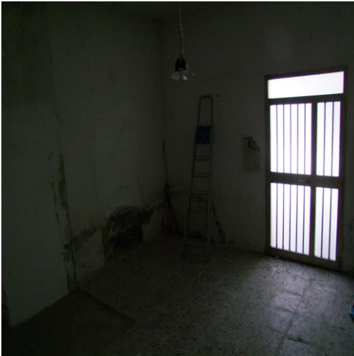
FOTO 21: INTERNO DEL RIPOSTIGLIO UBICATO AL PIANO TERRA, P.LLA 597 SUB. 1 (A/4)
