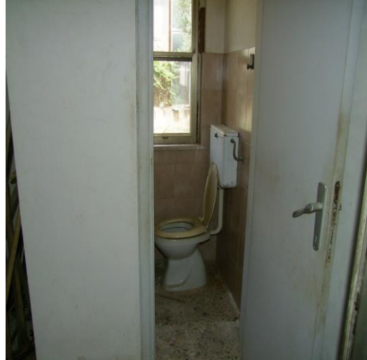
FOTO 34: ACCESSO AL W.C. UBICATO AL PIANO TERRA, P.LLA 597 SUB. 2 (C/2)
