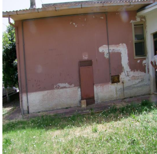
FOTO 30: CORTE ESCLUSIVA UBICATA AL PIANO TERRA, P.LLA 597 SUB. 1 (A/4)
