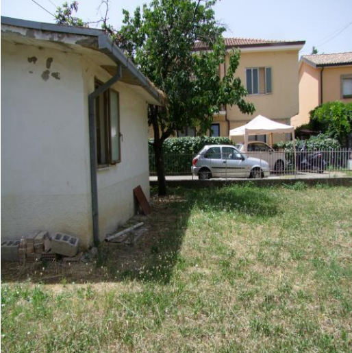
FOTO 29: CORTE ESCLUSIVA UBICATA AL PIANO TERRA, P.LLA 597 SUB. 1 (A/4)
