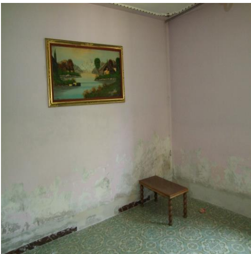
FOTO 23: INTERNO DEL SOGGIORNO UBICATO AL PIANO TERRA, P.LLA 597 SUB. 1 (A/4)
