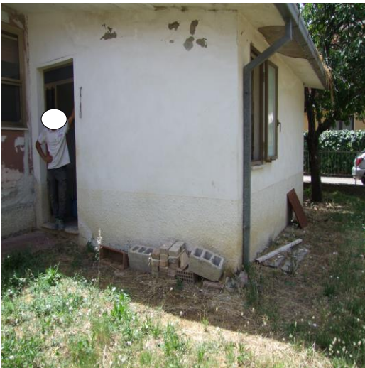
FOTO 31: ACCESSO AL DEPOSITO UBICATO AL PIANO TERRA, P.LLA 597 SUB. 2 (C/2)
