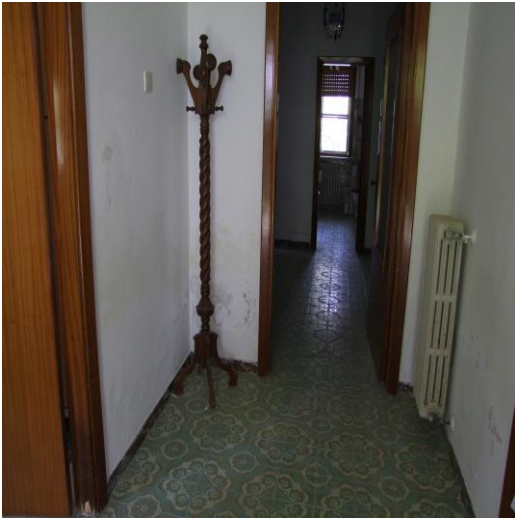
FOTO 13: INTERNO DELL'INGRESSO UBICATO AL PIANO TERRA, P.LLA 597 SUB. 1 (A/4)
