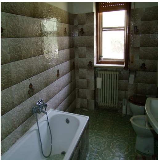
FOTO 19: INTERNO DEL BAGNO UBICATO AL PIANO TERRA, P.LLA 597 SUB. 1 (A/4)
