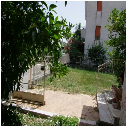
FOTO 25: CORTE ESCLUSIVA UBICATA AL PIANO TERRA, P.LLA 597 SUB. 1 (A/4)
