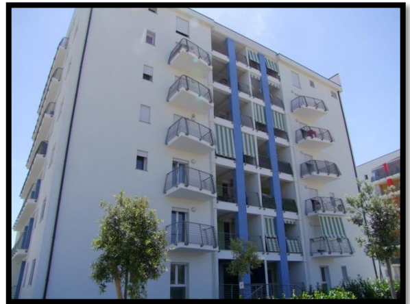
F. 04: FABBRICATO PLURIFAMILIARE UBICATO IN VIA GIUSEPPE SPATARO, N. 4/C, QUARTIERE SANTA RITA, LANCIANO (CH), P.LLA 4478
