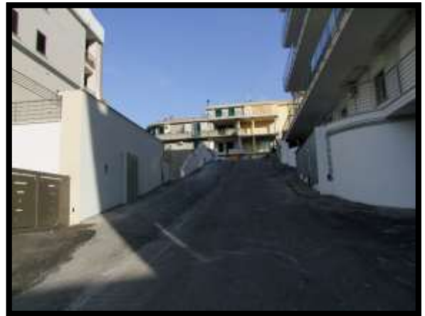
F. 34: ACCESSO CARRABILE AL GARAGE N. INT. "2" UBICATO AL PIANO 2° SEMINTERRATO IN VIALE PERTH, N. 54/BIS/E VASTO (CH)
