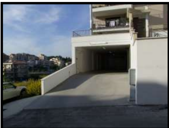
F. 34: ACCESSO CARRABILE AL GARAGE N. INT. "2" UBICATO AL PIANO 2° SEMINTERRATO IN VIALE PERTH, N. 54/BIS/E VASTO (CH), P.LLA 5691 SUB. 7 (B.C.N.C.)
