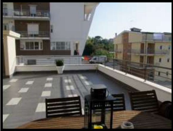
F. 13: TERRAZZO DELL'APPARTAMENTO INT. "1" UBICATO AL PIANO 1° SEMINTERRATO IN VIALE PERTH, N. 54/BIS/E VASTO (CH), P.LLA 5691 SUB. 25 (A/2)
