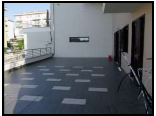
F. 22: TERRAZZO DELL'APPARTAMENTO INT. "1" UBICATO AL PIANO 1° SEMINTERRATO IN VIALE PERTH, N. 54/BIS/E VASTO (CH), P.LLA 5691 SUB. 25 (A/2)
