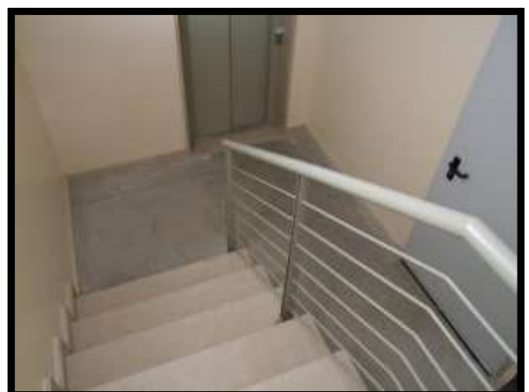
F. 30: ACCESSO AL GARAGE N. INT. "2" UBICATO AL PIANO 2° SEMINTERRATO IN VIALE PERTH, N. 54/BIS/E VASTO (CH), P.LLA 5691 SUB. 3 (B.C.N.C.)
