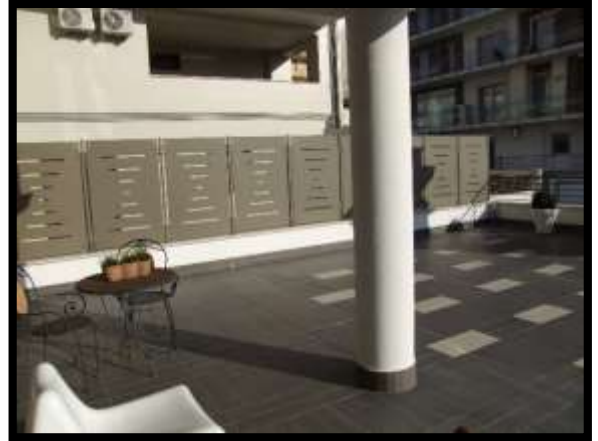
F. 14: TERRAZZO DELL'APPARTAMENTO INT. "1" UBICATO AL PIANO 1° SEMINTERRATO IN VIALE PERTH, N. 54/BIS/E VASTO (CH), P.LLA 5691 SUB. 25 (A/2)
