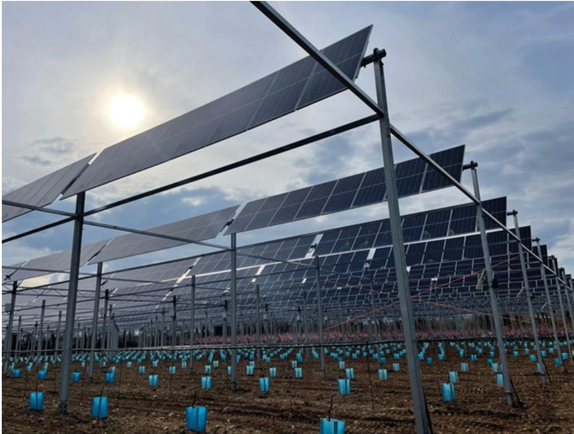
*Impianto agrivoltaico di Sun'agri, progetto pilota per combinare la produzione di energia con la coltivazione di ciliegie, pesche e albicocche.
